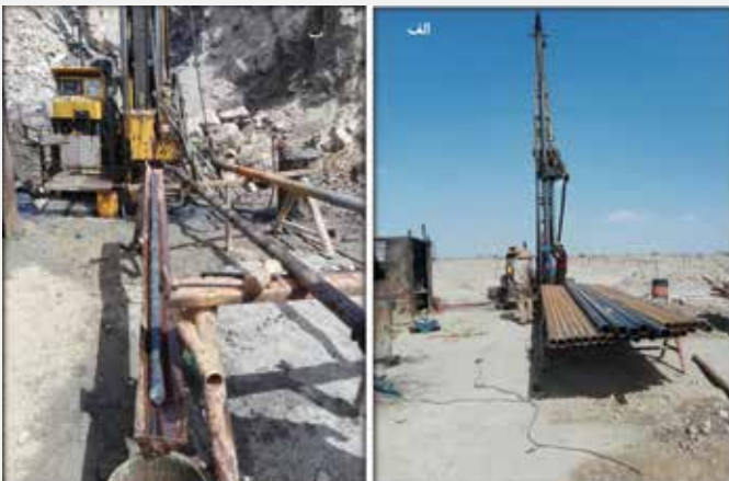
شکل (۲): الف- دستگاه حفاری CS14 در حال حفاری اکتشافی مغزه گیری با قطر HQ؛ ب- مغزه حاصل از حفاری گمانه ۳۲۱۵
